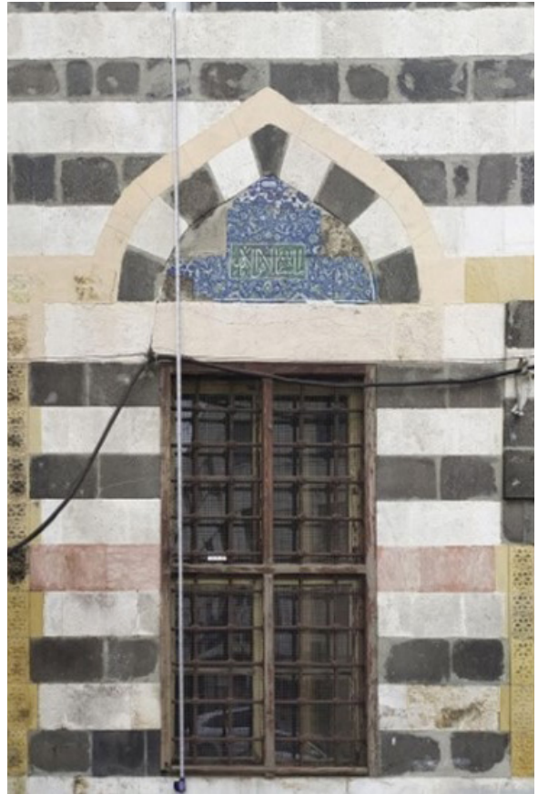
الشكل رقم (٢٨). تعليق المتر المعدني في الكوة لقياس العناصر الشاقولية (الباحثون)
